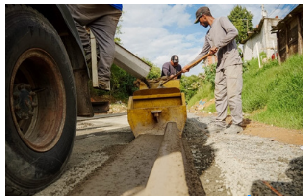
As obras avançam em 14 ruas do Água Fria, com meta de asfaltar 100% do bairro
